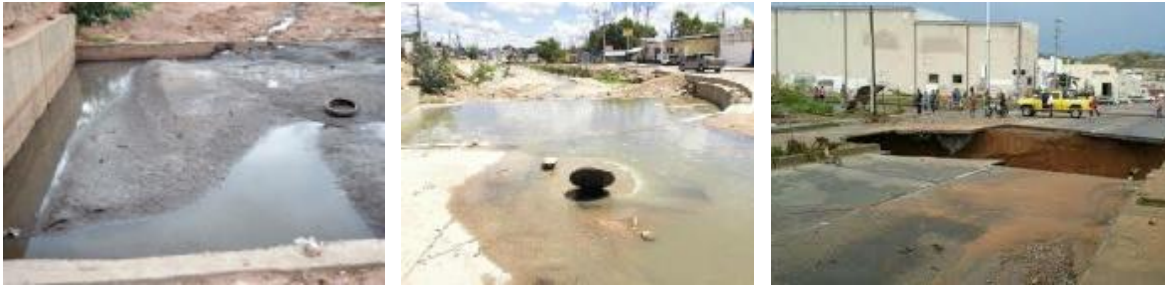
Figura 16. Problemas con el drenaje en el Centro de Población de Nogales
