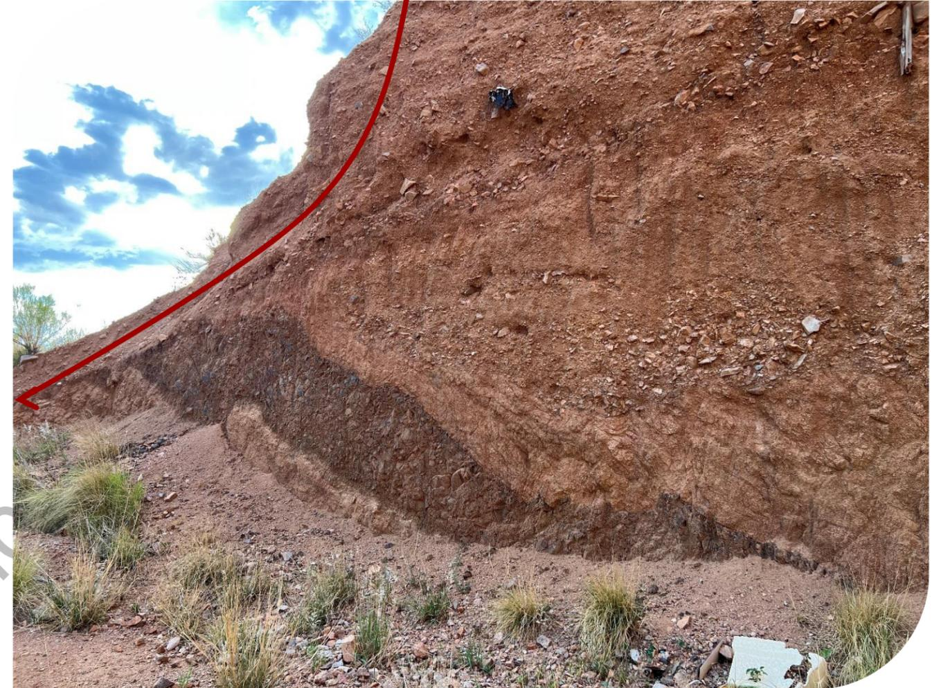
Imagen 22. Desprendimiento de material terreo debido a un deslizamiento rotacional.
